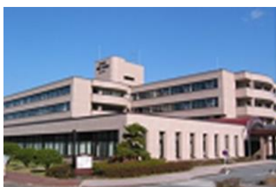
循環器・呼吸器病センター
