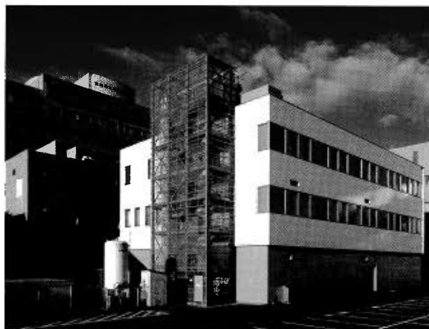
集学治療棟の外観
