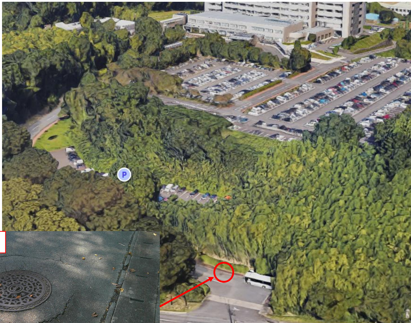
車道マンホール舗装 7
